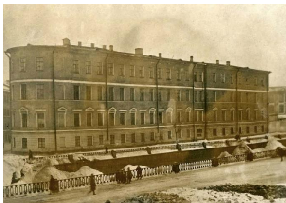
Рис. 1. Здание ЛИТМО по Демидову переулку дом 10 (зима 1940 года)
